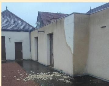
*Une partie de l'enduit d'un mur extérieur de la salle des fêtes est tombée. Afin d'éviter toute infiltration, des travaux seront entrepris.*
